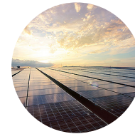
Beratungen zu Photovoltaikanlagen und Batteriespeichern
